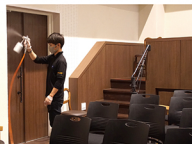
サーラ・アリエッタの施工風景
